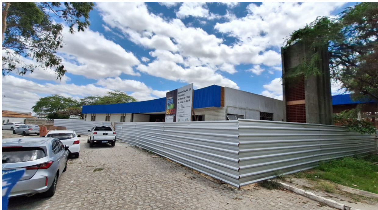
Vistoria nas Obras do Terminal de Belo Jardim - 16/12/25
